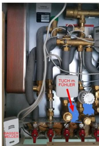
Wie bereits in der letzten Ausgabe erwähnt, ist in den Wohnungsstationen der Heizungsanlage eine Art Sollbruchstelle vorgesehen, die bei einem Defekt der wichtigen Dichtungen zwischen Heiz- und Brauchwasser zum tropfenweisen Austritt von Wasser an der mit Pfeil gekennzeichneten Stelle führt. Leider ist das im Block C schon dreimal passiert, zweimal in der selben Wohnung.
